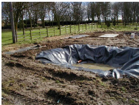
Obr. 25 a 25: Jako alternativu k betonu lze biobed ohraničit také plasty, jako např. EPDM (vlevo, zdroj ADAS) a PE kontejnery (vpravo, zdroj Mybatec).
