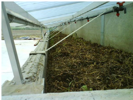
Obr. 23 a 24: Rozvedení kontaminované kapaliny po ploše pomocí rozstříkacích trysek (vlevo, zdroj POVLT) nebo kruhových perforovaných trubek (vpravo, zdroj Bayer CropScience)
