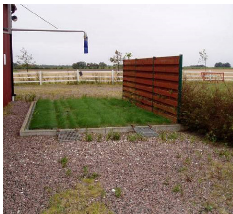
Obr. 28 a 29: Travnatá vrstva navrchu přímo plněného biobed (vlevo, zdroj Visavi) a Carex spp. v koncové jednotce modifikovaného biofiltru (vpravo, zdroj pcfuit)
