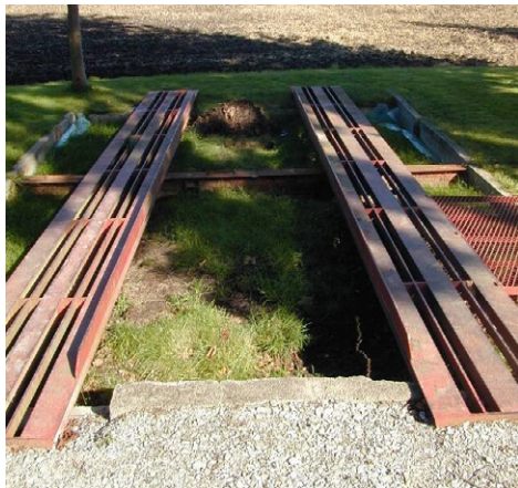
Obr. 11: Rampy nad biobed (zdroj: Visavi)
