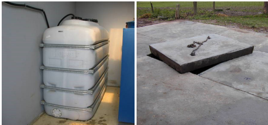
Obr. 18 a 19: Příklad 4000 l PE vyrovnávací nádrže nad zemí a 5000 l betonové vyrovnávací nádrže pod plnicím a čistícím místem se separačním ventilem na dešťovou vodu (zdroj: pcfruit )
