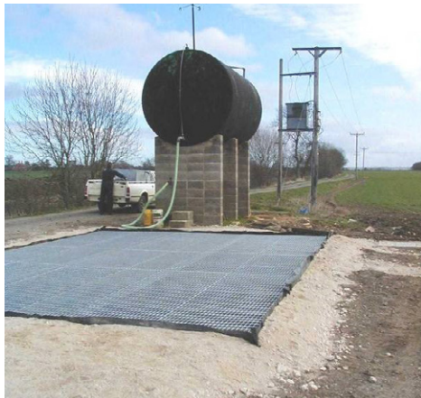
Obr. 12: Nájezdová mříž nad biobed
