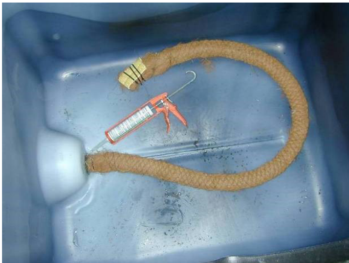
Obr. 27: Drenážní trubka na dně biofiltrační jednotky
